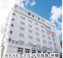
ホテルピースランド石垣島/外観
