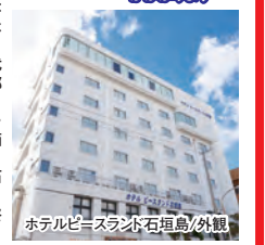
ホテルピースランド石垣島/外観
